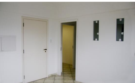
Sala 1 com 14 m 2 e ar condicionado
