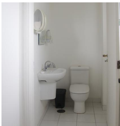
Banheiros em estado de novo
