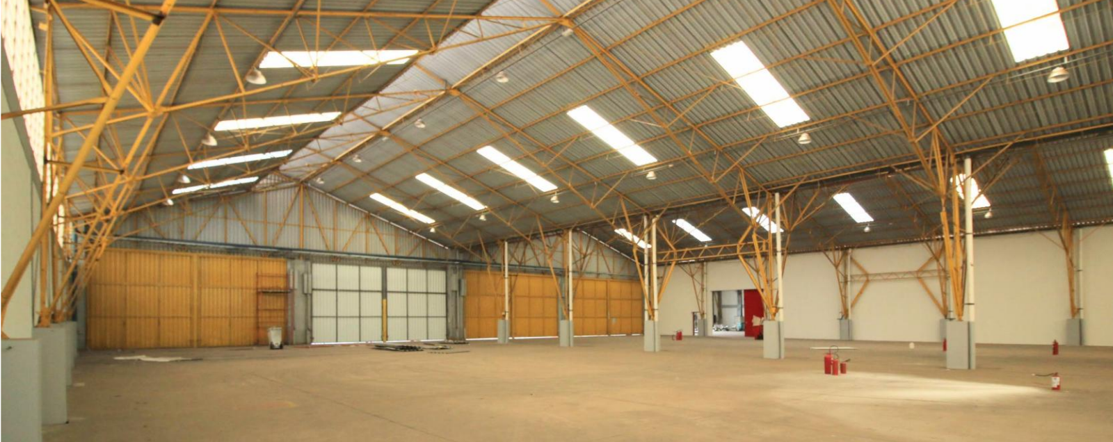
Vista interna do módulo principal do galpão 1.
