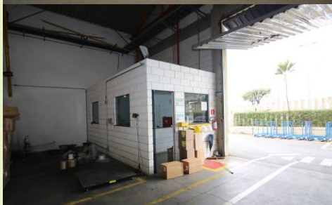
Portão auxiliar com vão livre de 6,72 x 4,00 m, nos 2 galpões.
