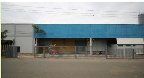
Portões de entrada e saída de caminhões, carros e pedestres controlados à distância. Quatro docas para caminhões com acesso ao galpão 1.
