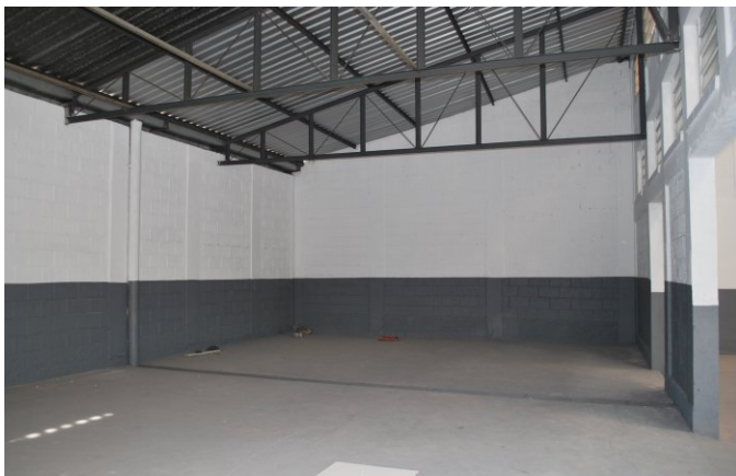
• Depósito coberto interligado com o galpão principal.
